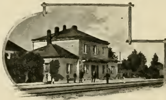
Abb. 254. Station Praeloné. [Brünn-Prag.] [Nördliche Staatsbahnen 1849.]
